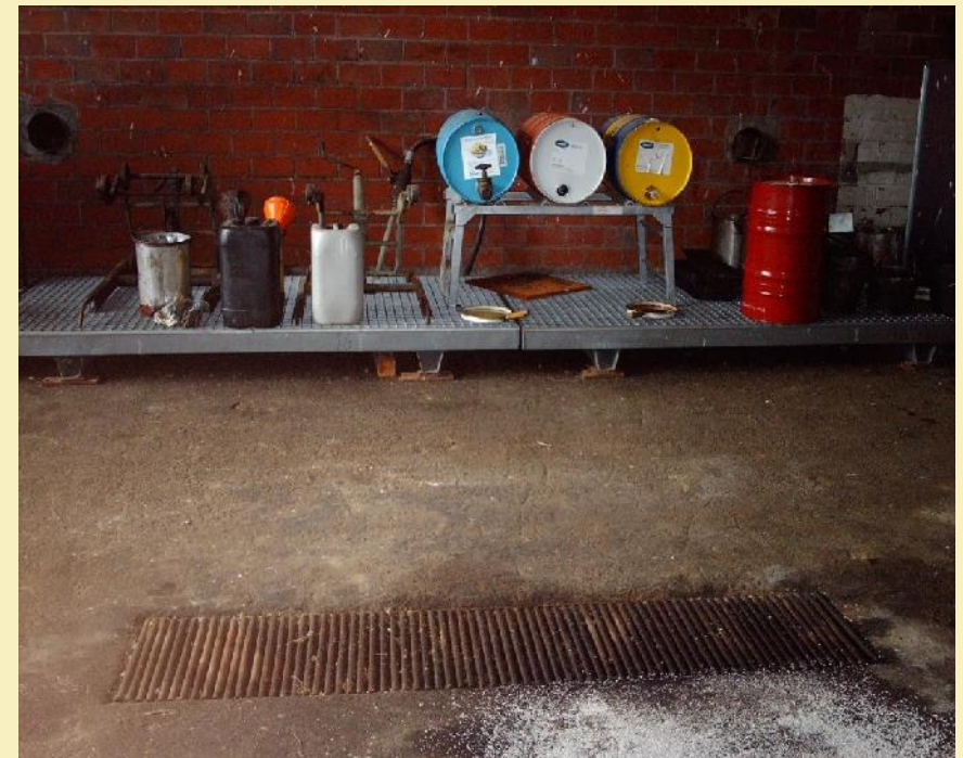
Dichte Betonmulde unter Gitterrost, Ölbindemittel verteilt
