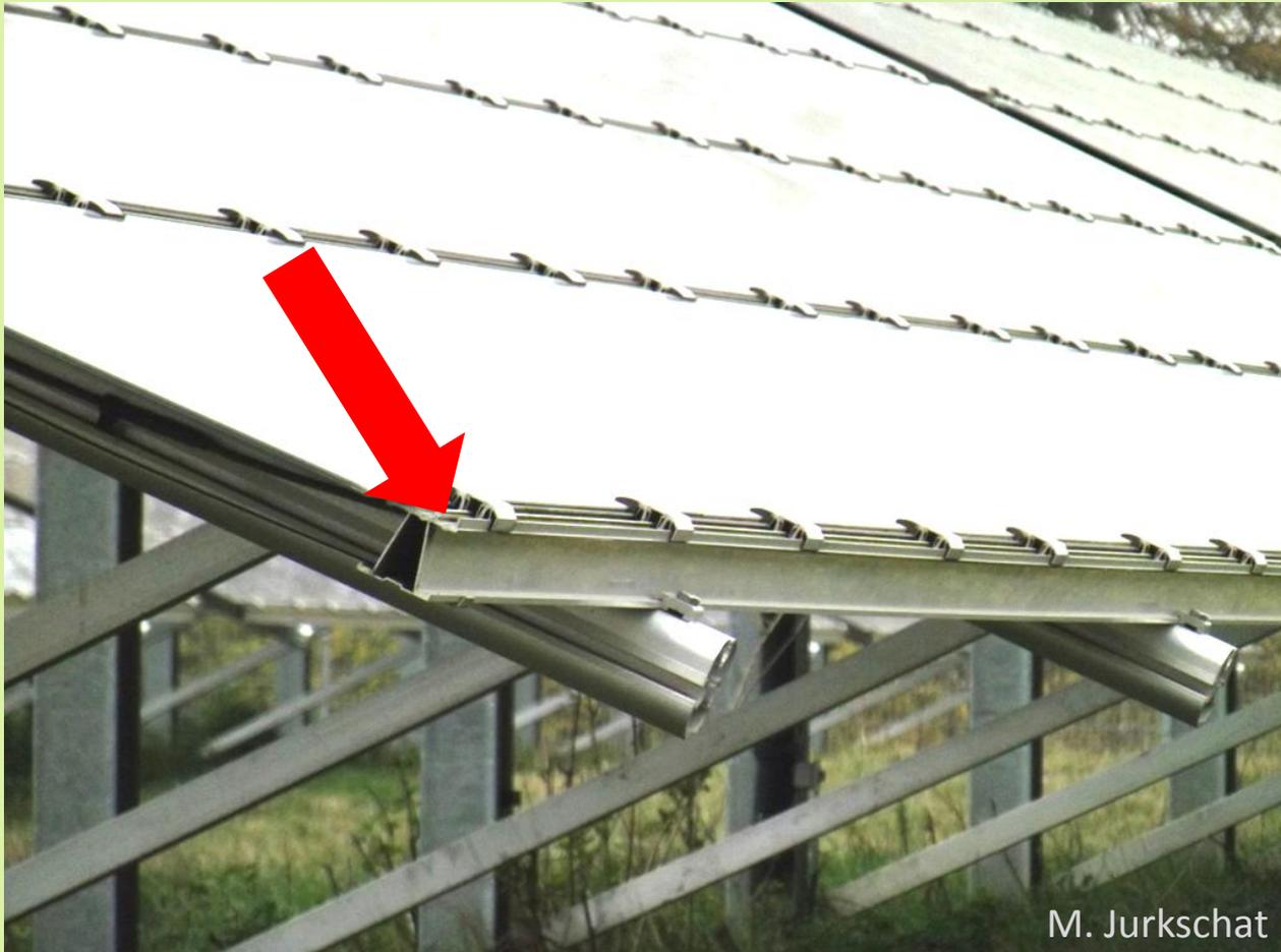
→ an der Modul-Unterkante Verstärkung zu empfehlen, z.B. durch Schienen bei Dünnschichtmodulen
