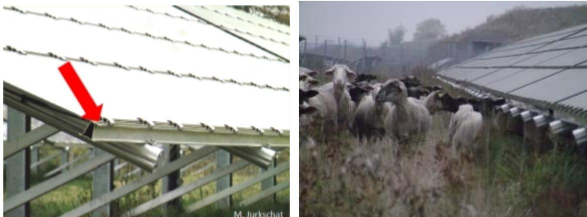
*Abbildung 10 a und b: Stabil aufgehängte Dünnschichtmodule - Selbst bei niedriger Höhe werden Anlagen mit Dünnschichtmodulen bei dieser Art der Aufhängung mit großen Schafen problemlos beweidet (Fotos: JURKSCHAT & SCHALOW 2014).*
