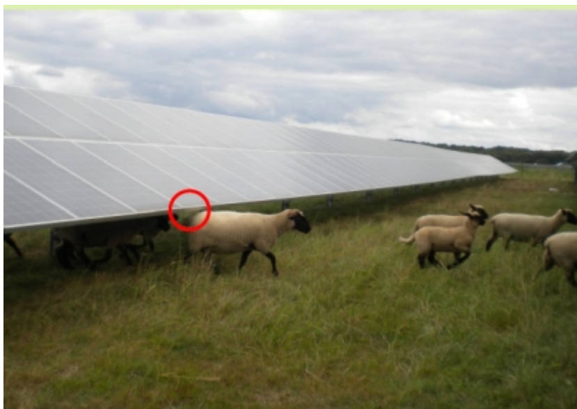
Abbildung 8: Die Mindesthöhe der Solarpaneele sollte 80 cm sein (Foto: SCHALOW 2013).
