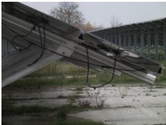
Abbildung 13: Freihängende Kabel stellen eine Gefahr für die Tiere und die Funktionalität der Panele dar (Foto: M. Jurkschat).
