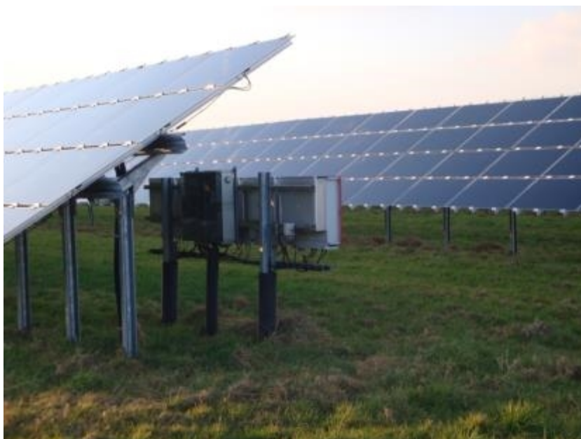
Abbildung 23: Wechselrichter müssen vor einer Schafbeweidung umzäunt oder anderweitig gegen Verbiss gesichert werden (Foto: K. Gerdes, Solarpark Fliegerhorst Oldenburg).
